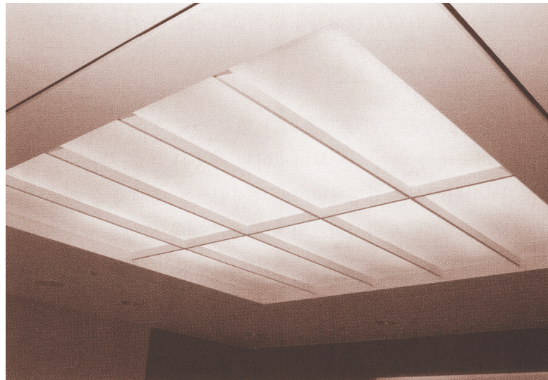
가피패널을 천정에 설치한 모습
